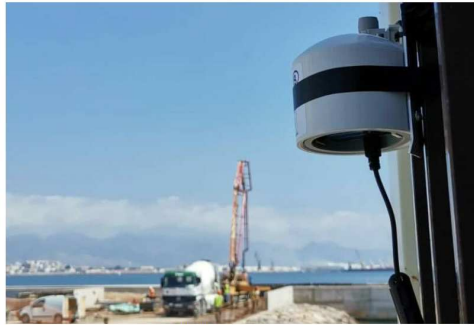
Sensores en PortCastelló instalados por el ITC-AICE y el CSIC.
